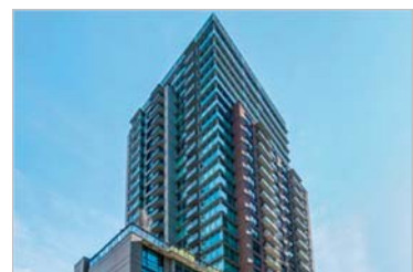
L'HERMITAGE 224 units Vancouver, Canada
